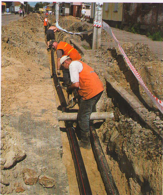
Бесканальная прокладка 300-500 метров трубы выполняется 3-4 монтажниками за одну смену
