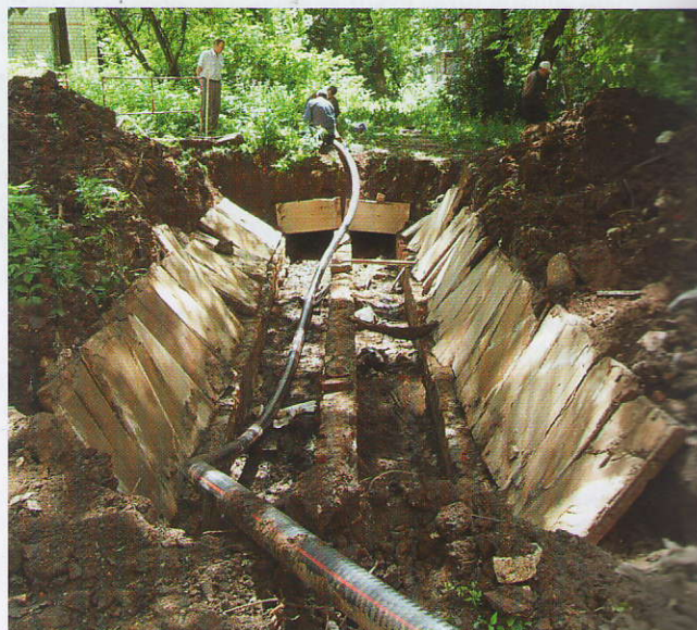
Монтаж сетей с частичным вскрытием существующих каналов
