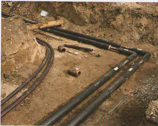
Нет необходимости в обустройстве компенсаторов, неподвижных опор, комплектации отводов
