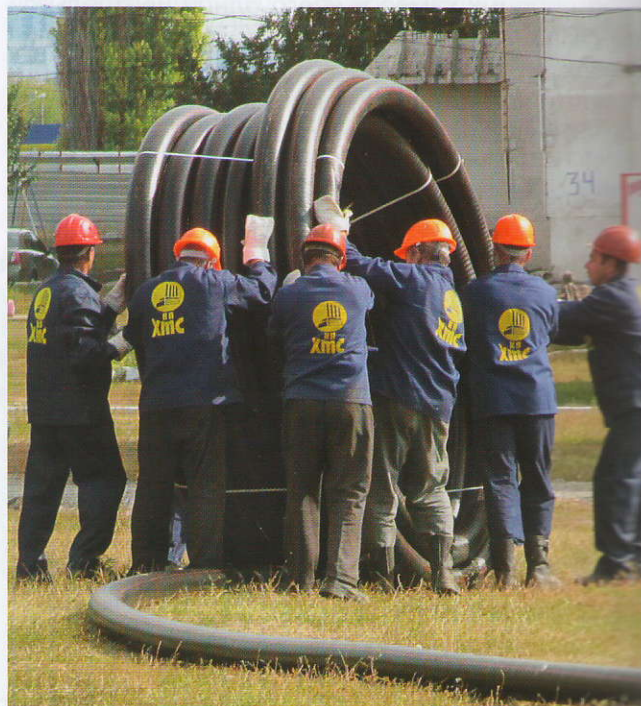
Труба поставляется на объект проектными отрезками — до 150-300 метров
